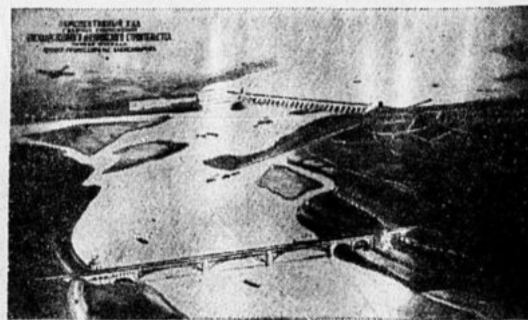
ВИД БУДУЩЕЙ ЭЛЕКТРОСТАНЦИИ НА ДНЕПРЕ.
